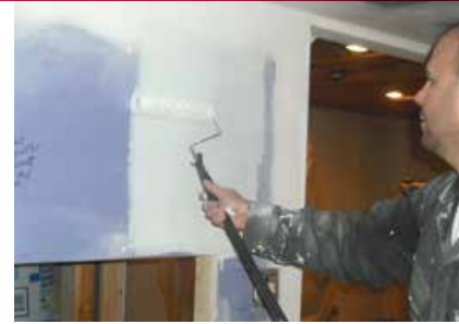
Applying primer to new drywall.
